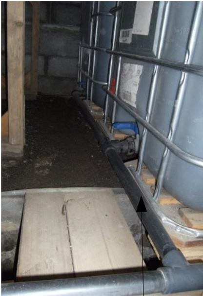
● canalisation de liaison des 3 réservoirs PVC  $\phi$ 40 alimentaire
