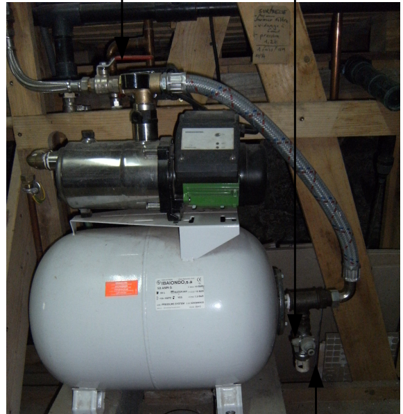
vanne 2 de départ sur réseau vanne V de vidange
